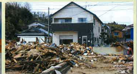
海岸から流されてきた倒壊家屋の残骸を受け止めることとなったT様邸。
